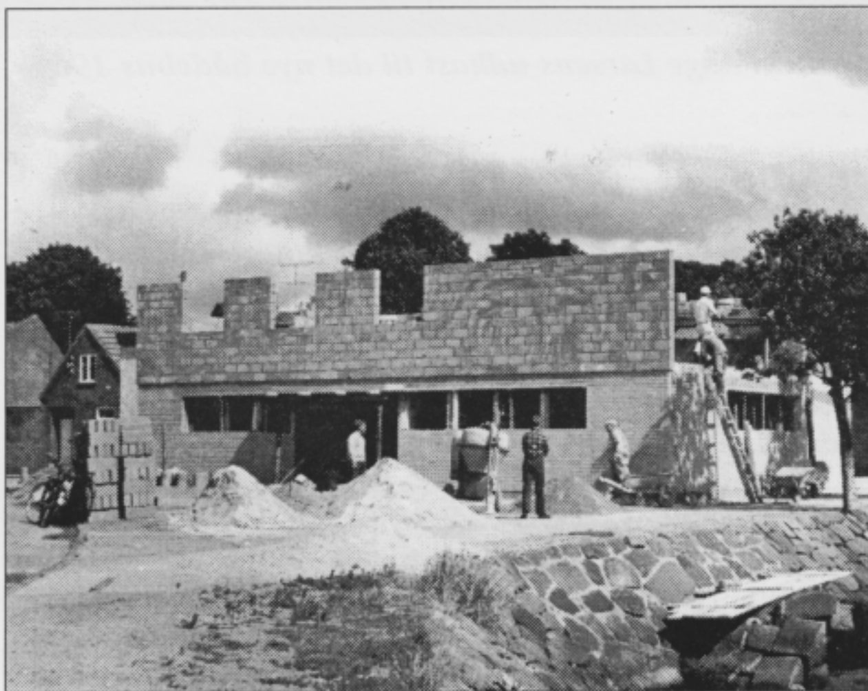
Opførelse af det nye bådehus 1964
