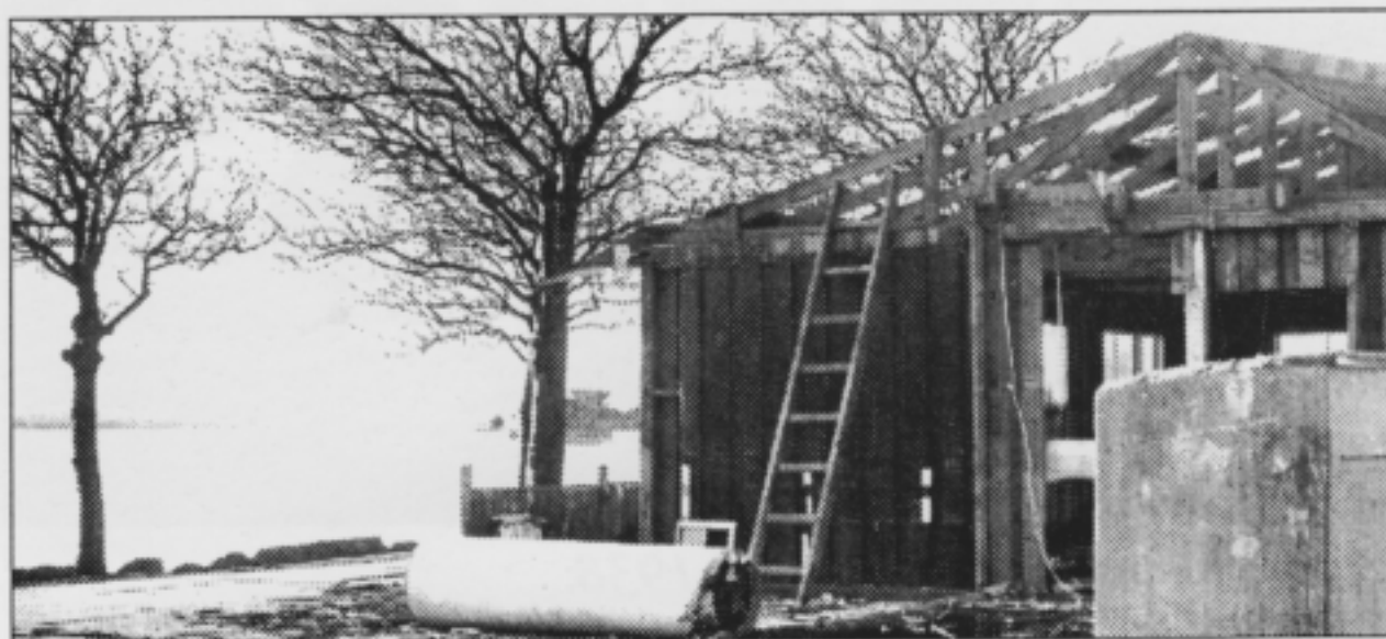
Tilbygningen til bådehuset under opførelse 1937
